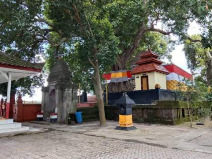
Gambar 3. Bangunan Siti Inggil. Sumber: Dokumentasi pribadi, 2022.
